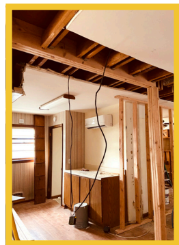
一楼打通隔间
