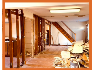
內部開工整修
