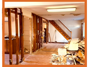
内部开工整修
